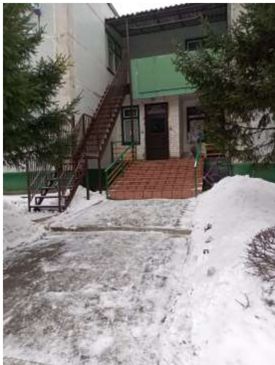
Центральный вход (фото 1)
